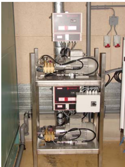
Voorbeeld van hogedrukpompen in duo-uitvoering.
